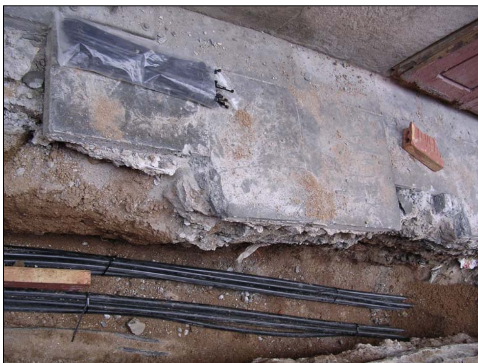
Fotografia 7: Col·locació del nou cable elèctric
