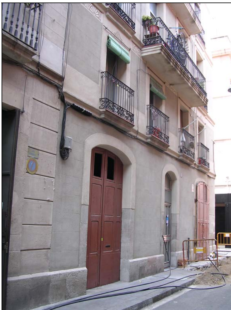
Fotografia 1: Finca St. Vicenç 35 on s'ha de portar la nova línia elèctrica.
