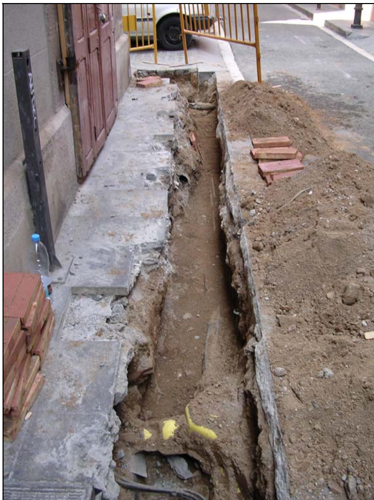
Fotografia 4: Rasa 1 amb diversos serveis
